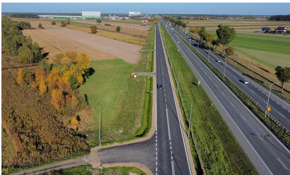
Droga gminna od węzła S8 Wola Rasztowska do obiektu logistycznego Żabka w Dąbrówce, fot. A. Taraszkiewicz, archiwum firmy Agbud, wykonawcy drogi
